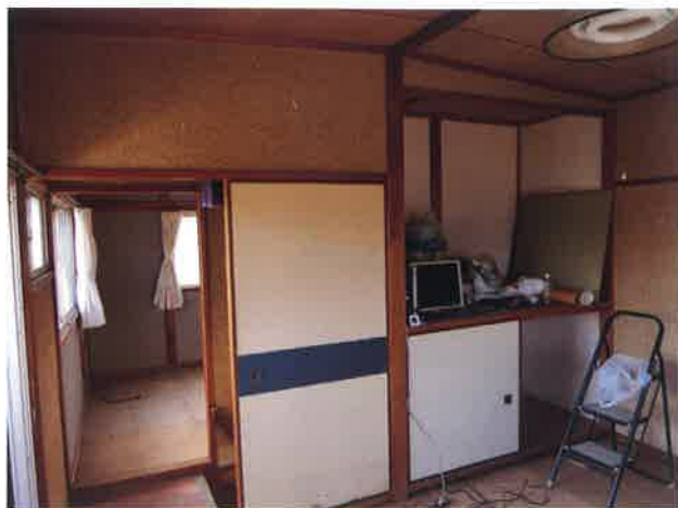
②工事前(2階)
