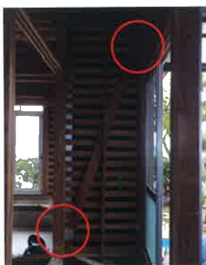
③既設筋交い 金物補強
