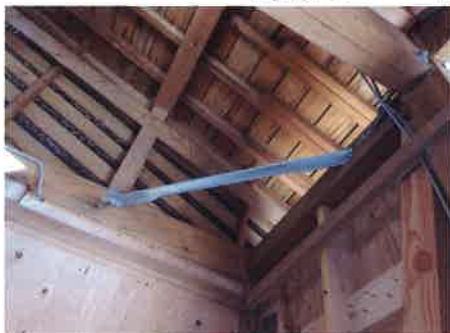
⑤新設火打ち梁
