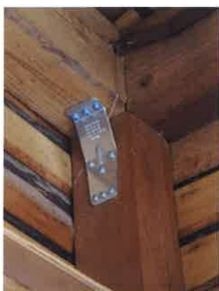
③接合部金物〈柱頭・柱脚〉 ※N値計算により算出した金物を取付
