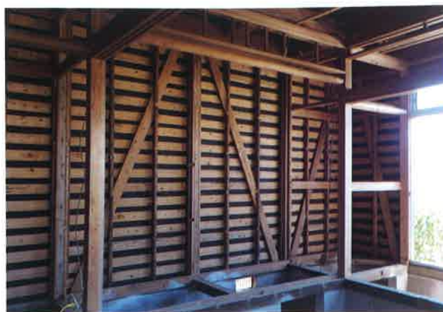
②工事前（筋交い）
