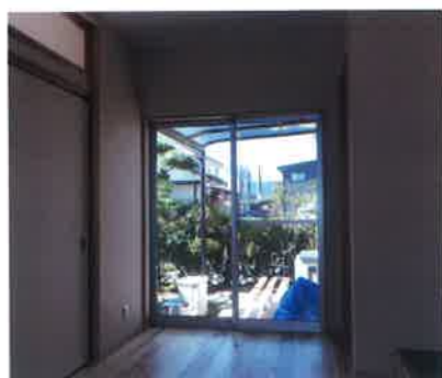
⑥サッシ復旧完了
