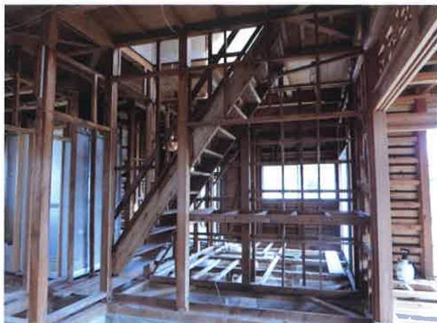
①工事前(1階)
