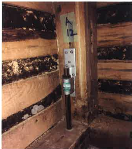
③接合部金物<柱頭・柱脚> ※N値計算により算出した金物を取付
