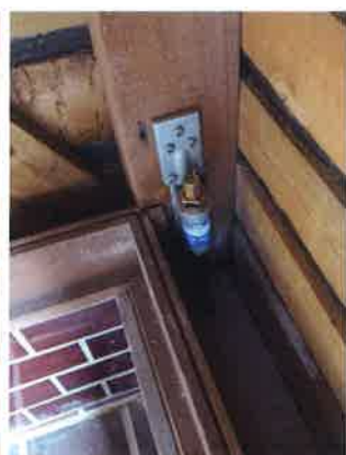
③接合部金物〈柱頭・柱脚〉 ※N値計算により算出した金物を取付
