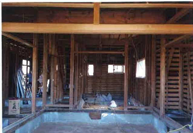
①工事前（1階）
