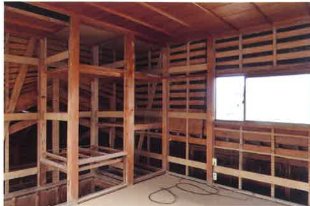
②工事前(2階)
