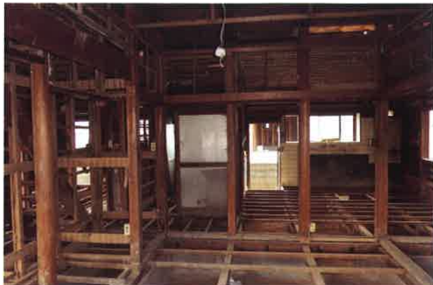
①工事前(1階)
