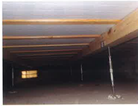
⑤床断熱材と床下土間 コンクリート
