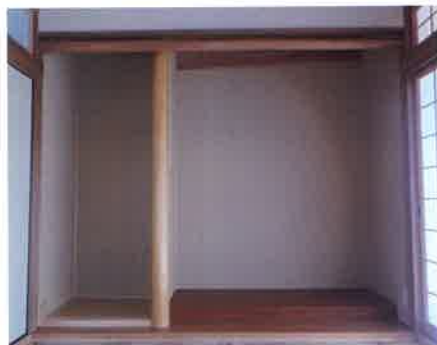
⑦完成（和室）
