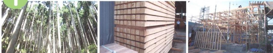
柱は12cm×12cm、梁桁は12cm×12cm・12cm×18cmを組み合わせたオール桧構造材の住宅をつくります。
