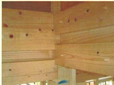
木材を上下に重ねてダボにより固定した「重ね梁」を施工した事例
