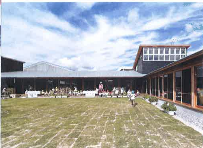
中庭から見る。一部を除いて木造平屋建てとし、園庭を囲む形で、保育室、遊戯室を配置。そこに「みんなですごす大きなおうち」の象徴としての大屋根を架けた
